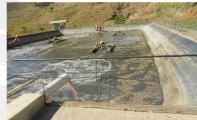
**Figura 2:** Vista do tanque de aeração da ETE do frigorífico
