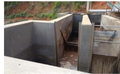
**Figura 1:** Calha Parshall com o gradeamento
