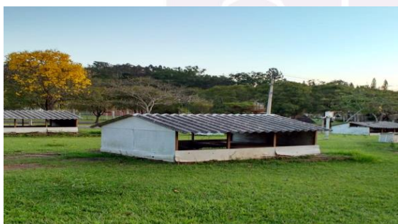
Figura 1. Vista frontal do protótipo com telha de fibrocimento.
