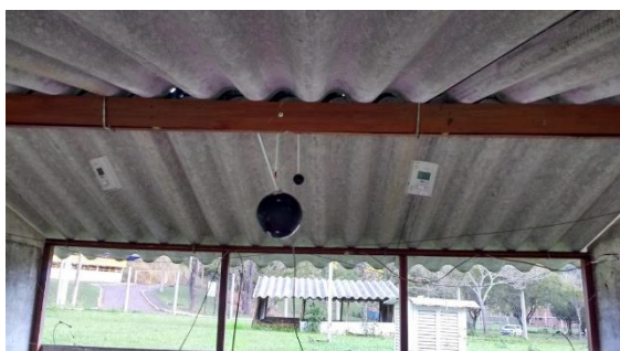
Figura 3. Vista interna do protótipo e do posicionamento dos equipamentos.
